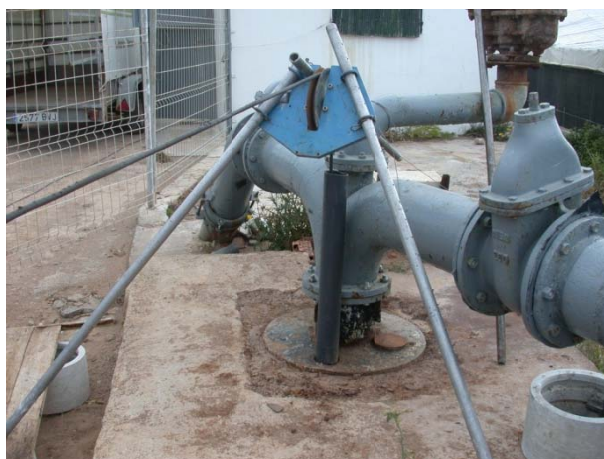
Figura c.1.1. - Instalación de tubo de PVC en el punto 622-D (AIO, área profunda)
