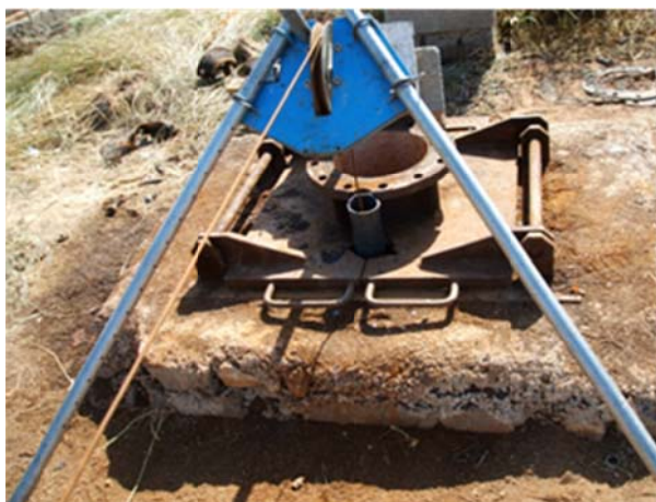
Figura c.1.3.- Instalación de tubo de PVC en punto 794-D (AIO, área de Tarambana)
